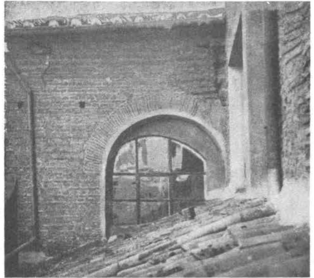
Fig. 37 — S. ANASTASIA — Muro occidentale del transetto Nord.
